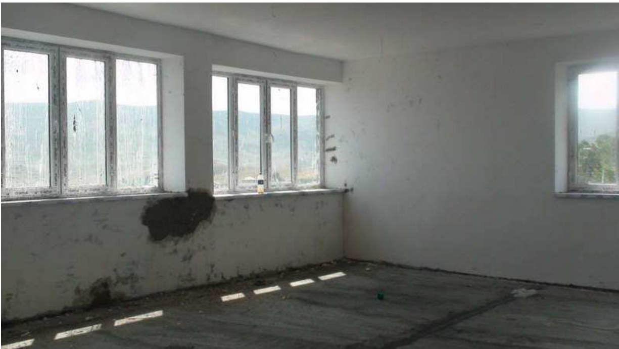
Intérieur en cours de rénovation
