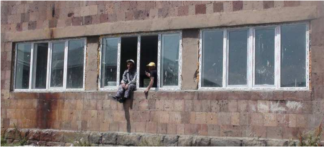
Nouvelles fenêtres posées sur la façade du bâtiment
